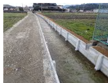
藤原宮跡角田池南方水路改修工事
