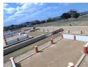
平城宮跡兵部省列柱表示(西)修繕工事
