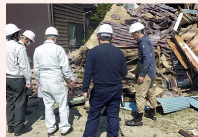
建造物の被災状況調査
