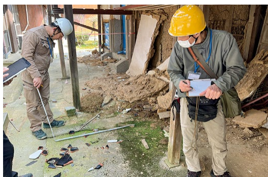
能登半島地震被災建造物調査の様子 (文化財防災センター)
