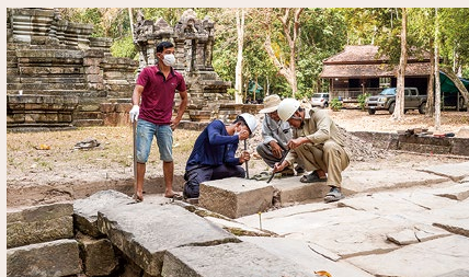
西トップ寺院仏教テラス東端の調査風景 (南東から)
