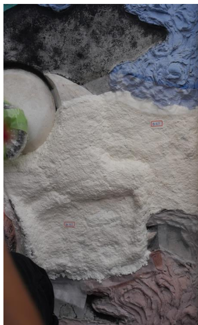
無機修復材料を用いたバック法による 補強処置の様子
