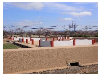
平城宮跡兵部省列柱表示(東)修繕工事
