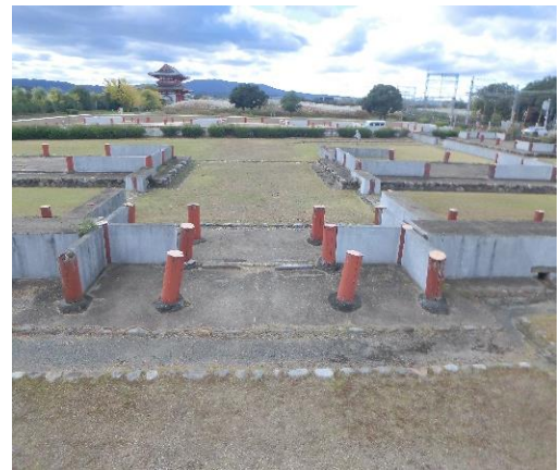
平城宮跡兵部省列柱表示の老朽化の状況
