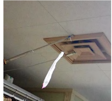
吹き出し口の温湿度測定と 気流調査の様子
