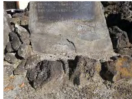
銘文の剥離が懸念されている、志木市指定有形民俗文化財中宗岡の御嶽塚
