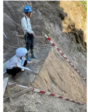
人吉市大村横穴群崩落地区の復旧方法に関する指導
