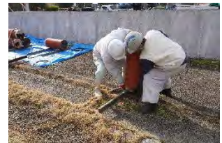
修理現場記録の様子
