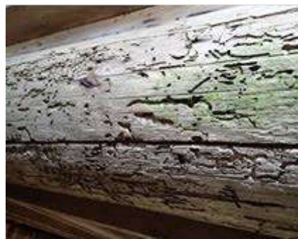
木造建造物の甲虫被害
