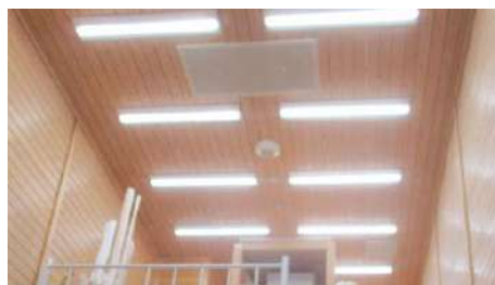
修復収蔵庫のLED化工事
