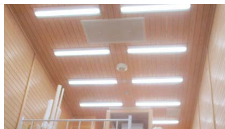
修復収蔵庫のLED化工事
