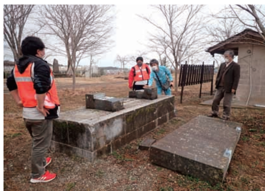
災害による被害状況現地調査
