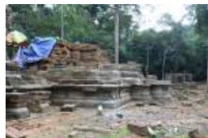
西北部の再構築状況
