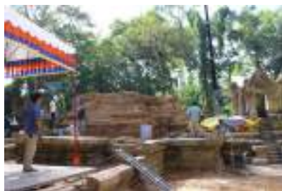
式典直前の再構築状況
