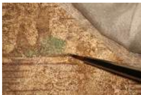
バイオフィルムの除去作業
