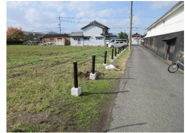
藤原宮跡民有地等境界柵整備状況
