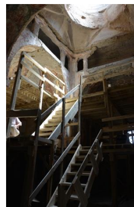
壁画保存の現場実地研修を行うタグル教会内部
