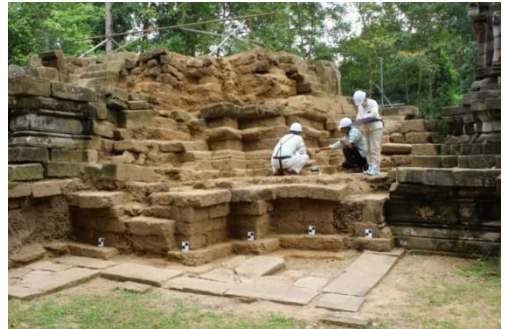
中央祠堂基壇西南部 砂岩外装解体後の調査
