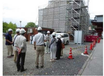
日光山中禅寺鐘楼の湿度制御温風処理の様子
