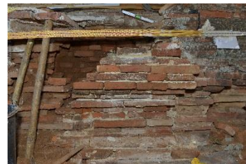
煉瓦造寺院の外壁調査
