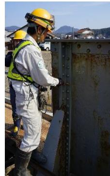
JR西日本と実施したリベット工法の性能評価に関する調査の状況
