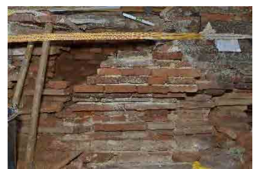
煉瓦造寺院の外壁調査
