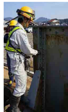
JR西日本と実施したリベット工法の性能評価に関する調査の状況
