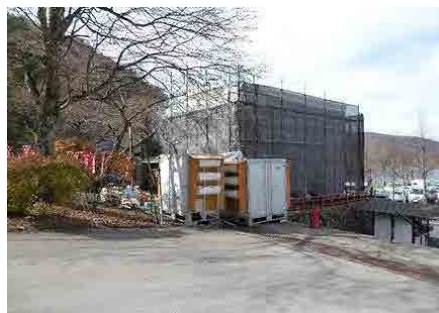
日光山内の社寺での加湿温風殺虫処理の様子
