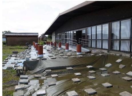
写真1 南棟南側地盤表面の防水処置
