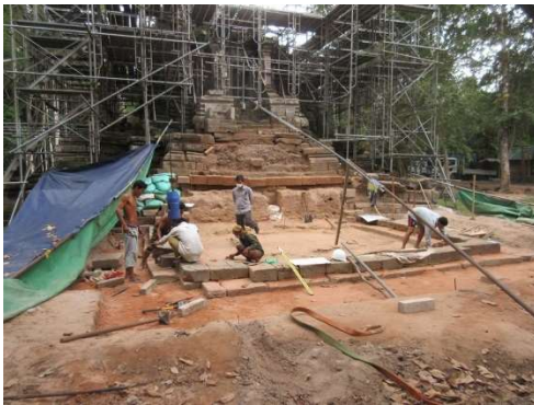
写真1 北祠堂 N24 再構築
