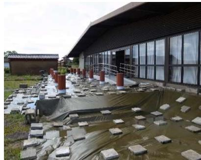
図 防水シート敷設による遺構劣化の抑制効果に関する検証
