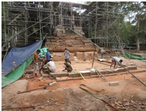
写真1 北祠堂 N24 再構築
