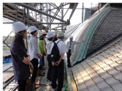
屋根修理現場他の見学会
