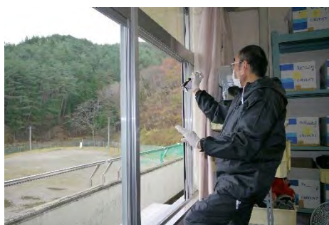
収蔵環境改善のための防虫施工
