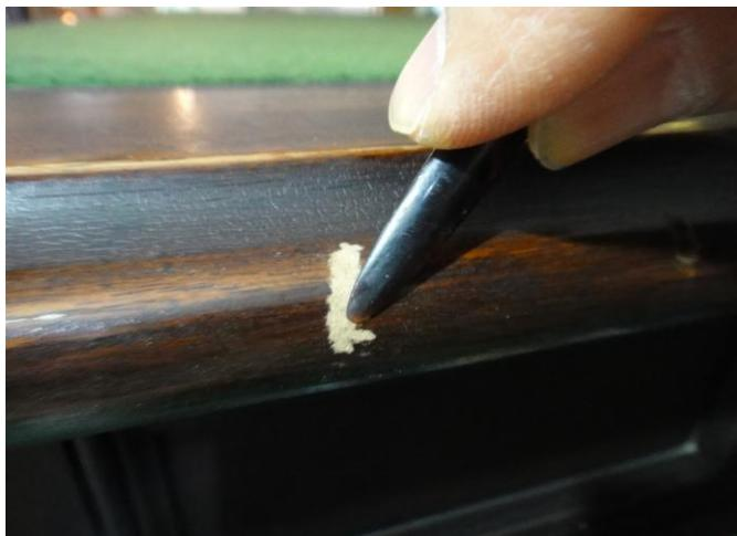
修復作業(損傷部の充填材の整形)
