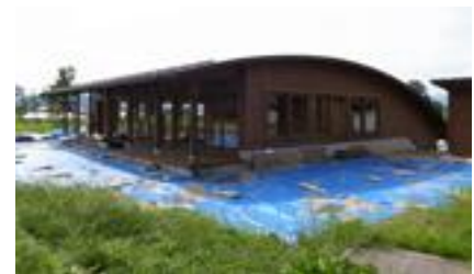
竣工した覆屋（宮畑遺跡）
