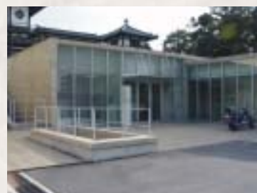
文化財保存修理所
