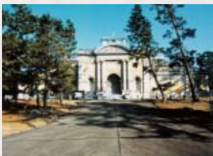
本館 明治28年(1895)開館。重要文化財
