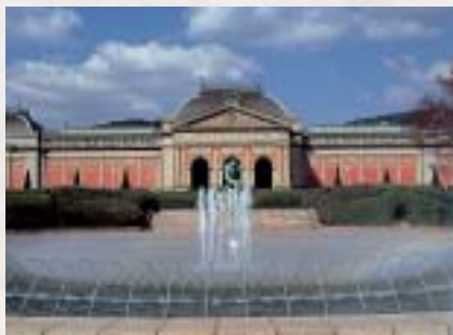
本館 明治30年(1897)開館。重要文化財
