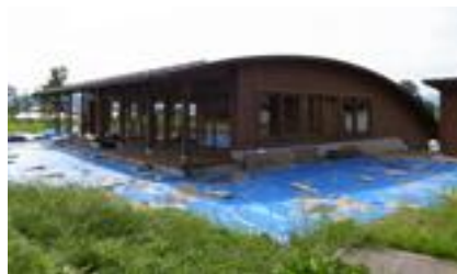
竣工した覆屋（宮畑遺跡）
