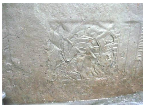
千足古墳石障の劣化状況
