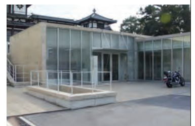
文化財保存修理所 Conservation Center for Cultural Properties
