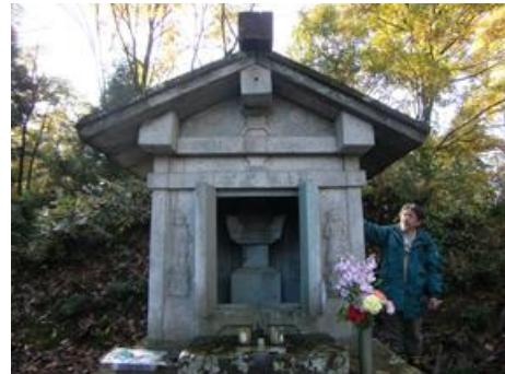
初代七女千世墓石廟。地震による石材の落下や基礎部分の石材の割れが認められ、構造的に不安定な状態にある。
