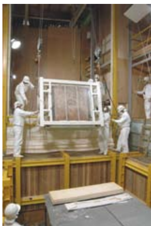
高松塚古墳壁画の 保存修理のための石室解体 (北の側石「玄武」の取り上げ) Removal of stone chamber from Takamatsuzuka tumulus for restoration of the murals
