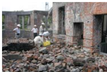
原爆ドームにおける煉瓦壁の調査 Investigation of the brick walls of the Hiroshima Peace Memorial (Genbaku Dome)
