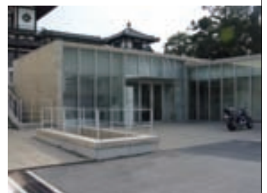
文化財保存修理所 Conservation Center for Cultural Properties
